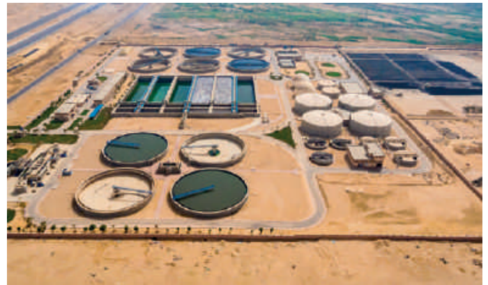
Vista aérea Planta de tratamiento de agua residual de New Cairo, Egipto
